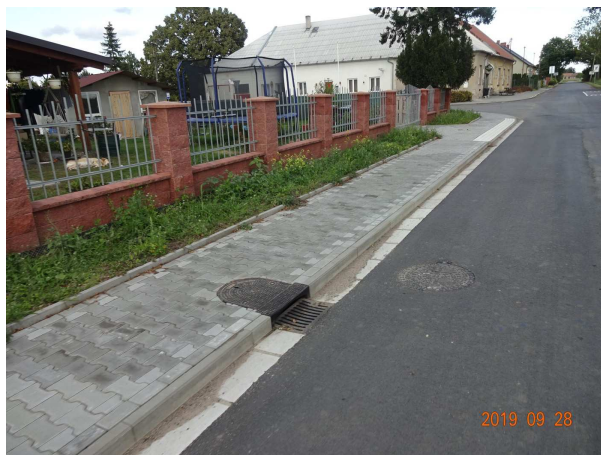
Obr. 1: Ilustrační foto obrubníkové uliční vpusti
