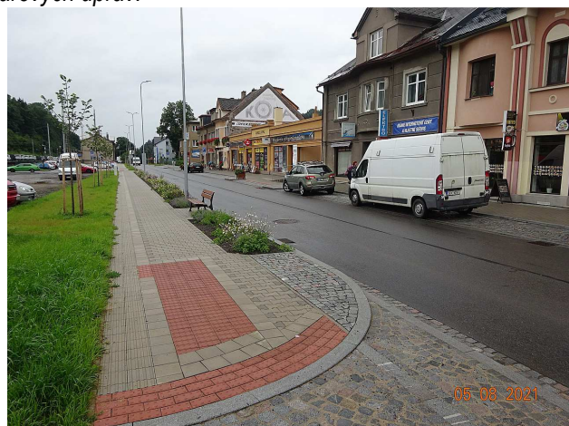
Obr. 3: Ilustrační foto kladení dlažby bezbariérového užívání – lemování prvků
