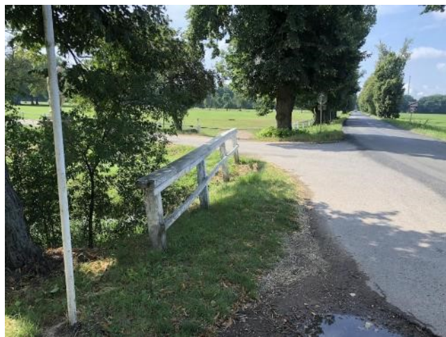
_Pohled na pravou římsu proti směru staničení
