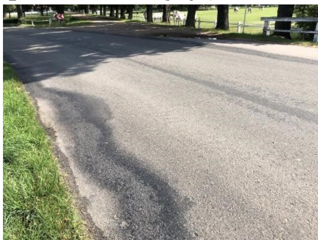
e _Vozovka na konci mostu (předpolí)
