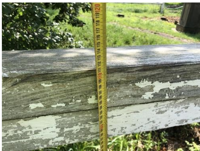
_dřevěné zábradlí vpravo má výšku 1100mm
