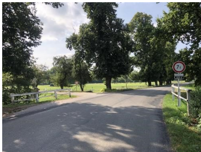
_Pohled na most proti směru staničení
