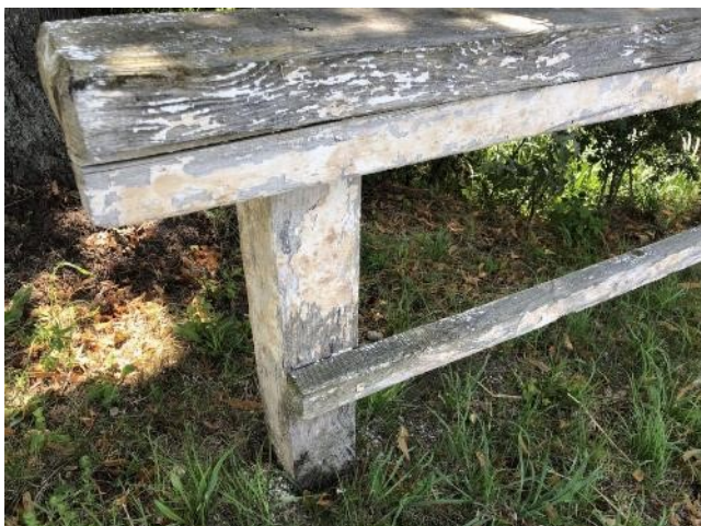
IMG_8312 - pravé zábradlí je mírně nestabilní a kýve se
