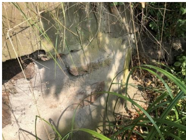
_Pravé křídlo na konci mostu (K4)
