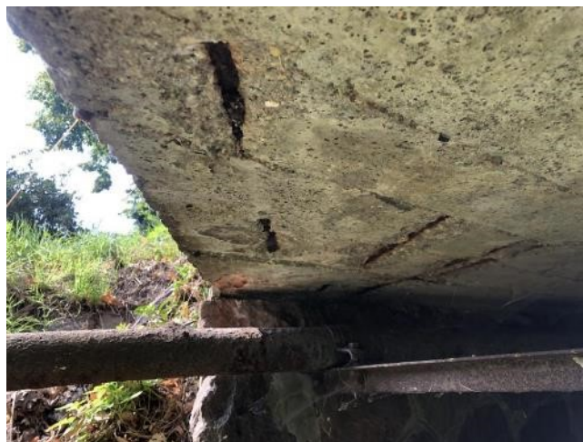
IMG_8363 - Na podhledu NK VPRAVO se vyskytují stopy po zatékání, obnažené třmínky i nosná výztuž, na
