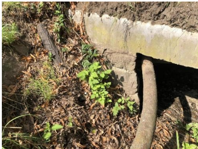
_Pravé křídlo na začátku mostu (K2)
