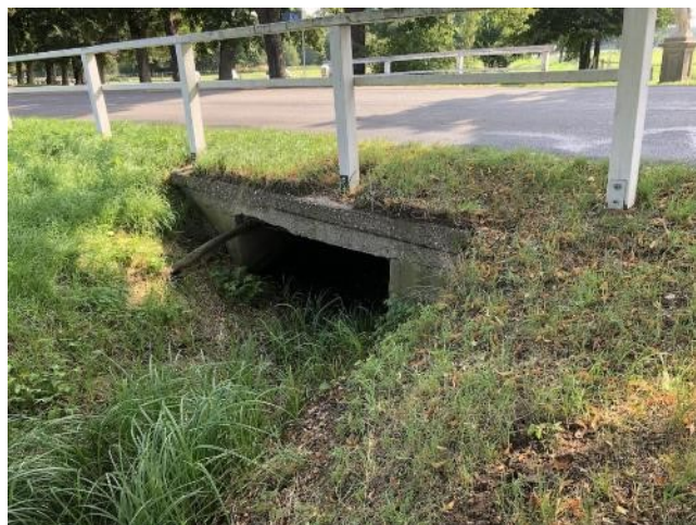
_Pohled na objekt zleva
