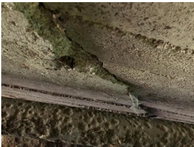
IMG_8358 - nezapravená pravděpodobně pracovní spára na podhledu NK
