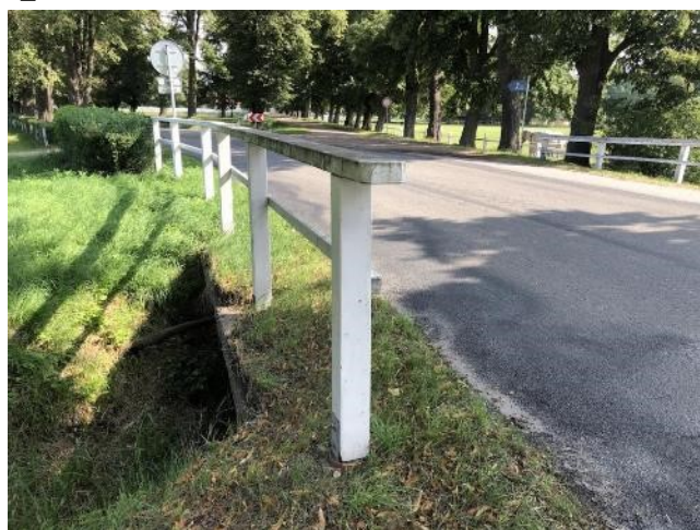
_Pohled na levou římsu po směru staničení
