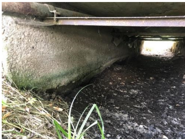
_Pohled na opěru O2
