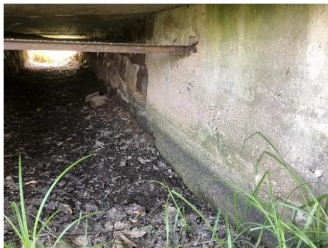
_Pohled na opěru O1
