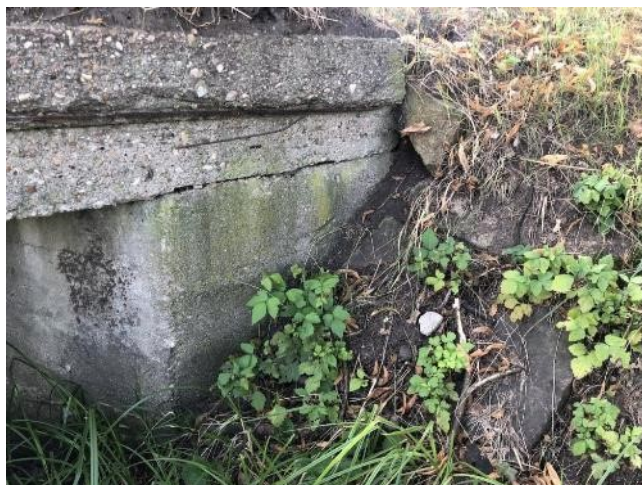
_Levé křídlo na začátku mostu (K1)
