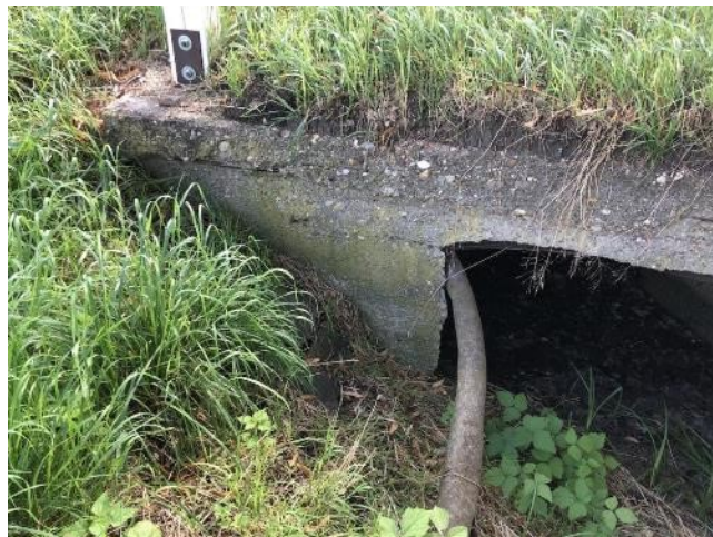
_Levé křídlo na konci mostu (K3)
