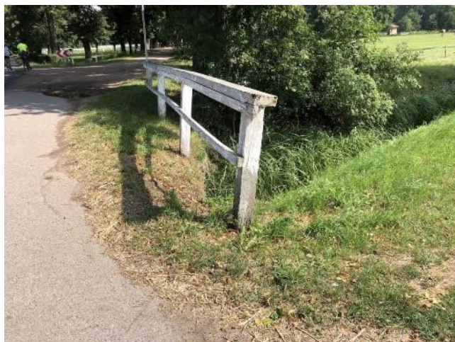
_Pohled na pravou římsu po směru staničení
