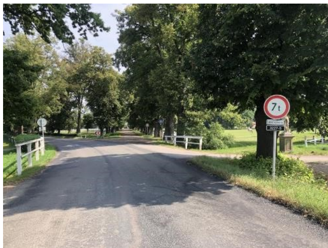
_Pohled na most po směru staničení
