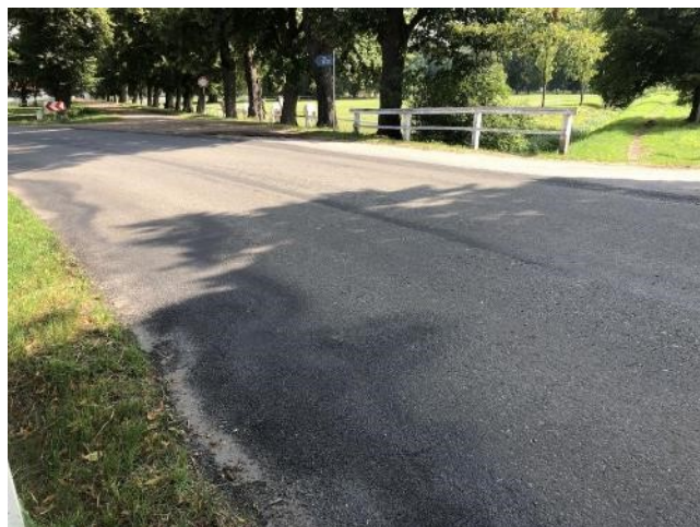
c _vozovka na mostě
