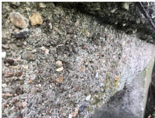
IMG_8350 - Levá boční plocha NK povrchově degraduje
