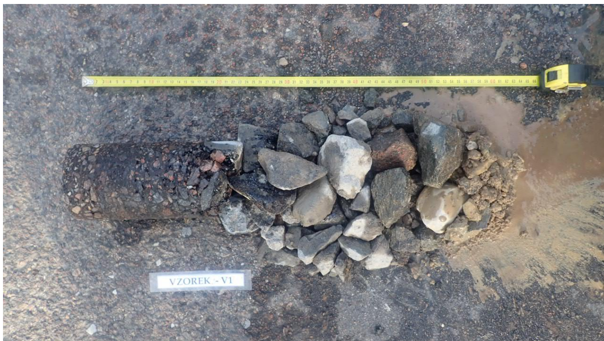
Obr. 1 - Jádro vývrtu Vzorek – V1 (in situ).
