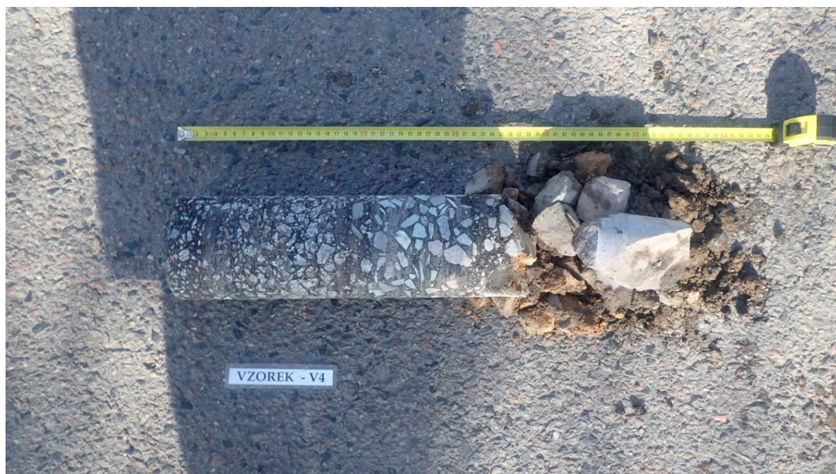
Obr. 7 - Jádro vývrtu Vzorek – V4 (in situ).
