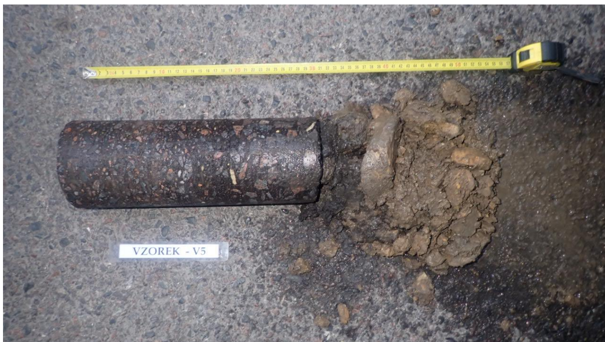
Obr. 9 - Jádro vývrtu Vzorek – V5 (in situ).
