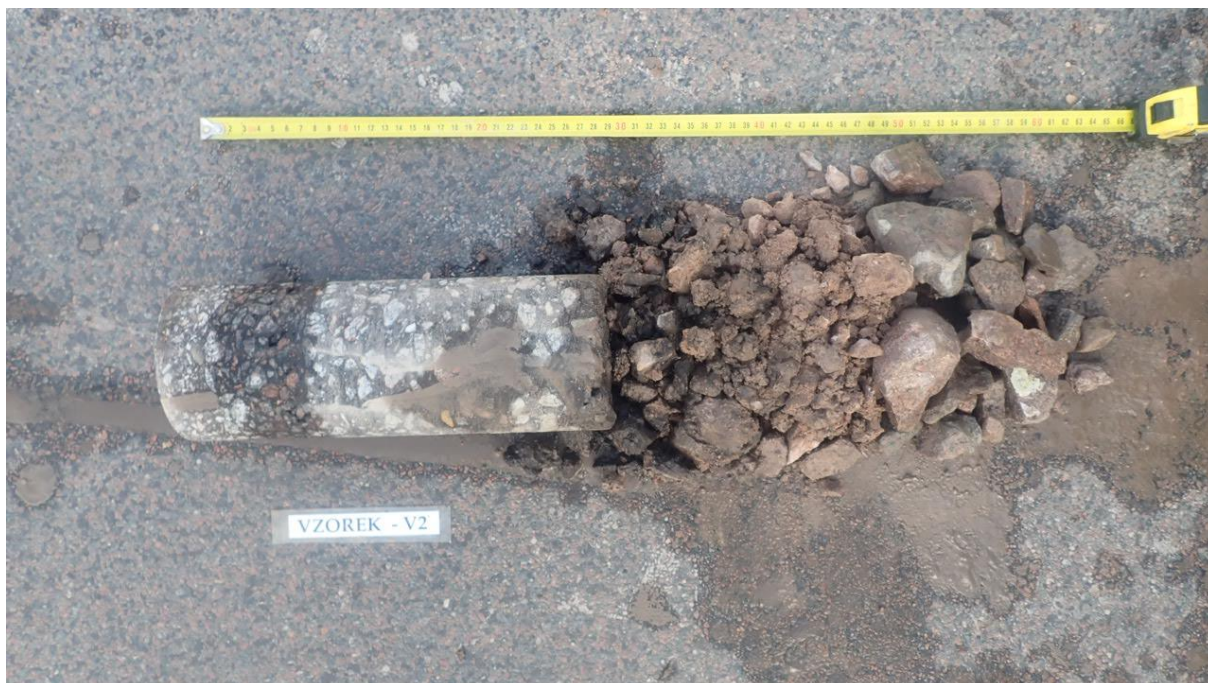
Obr. 3 - Jádro vývrtu Vzorek – V2 (in situ).
