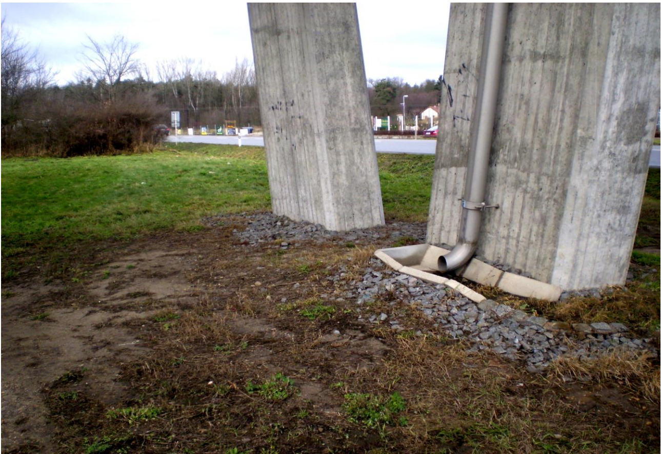
Podchycení svodu z nadjezdu vpustí vedle bet.žlábků, obvedení kanalizací DK 11
