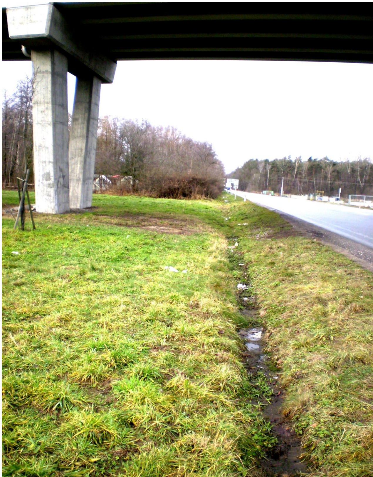
Levý silniční příkop ve kterém je vedena DK 1, za nadjezdem silniční vpust' UV 1 a níže pak BOX I.
