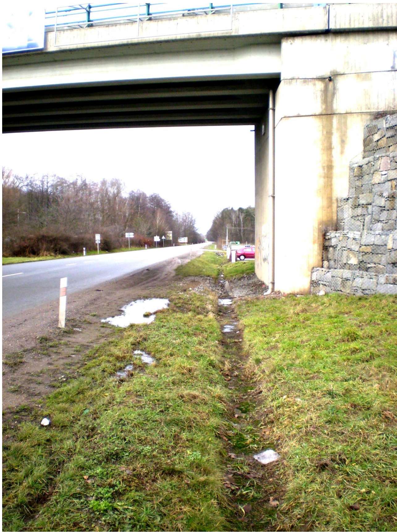
Pravý silniční příkopek, podchycení svodu nadjezdu, za nadjezdem sil. vpust' UV 2, níže pak BOX II.
