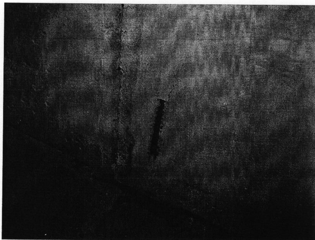
Foto 3: odlupující se povrchové vrstvy betonu vlivem koroze výztuže a expanzních tlaků vyvolaných korozními zplodinami. Povrchová koroze výztuže.
