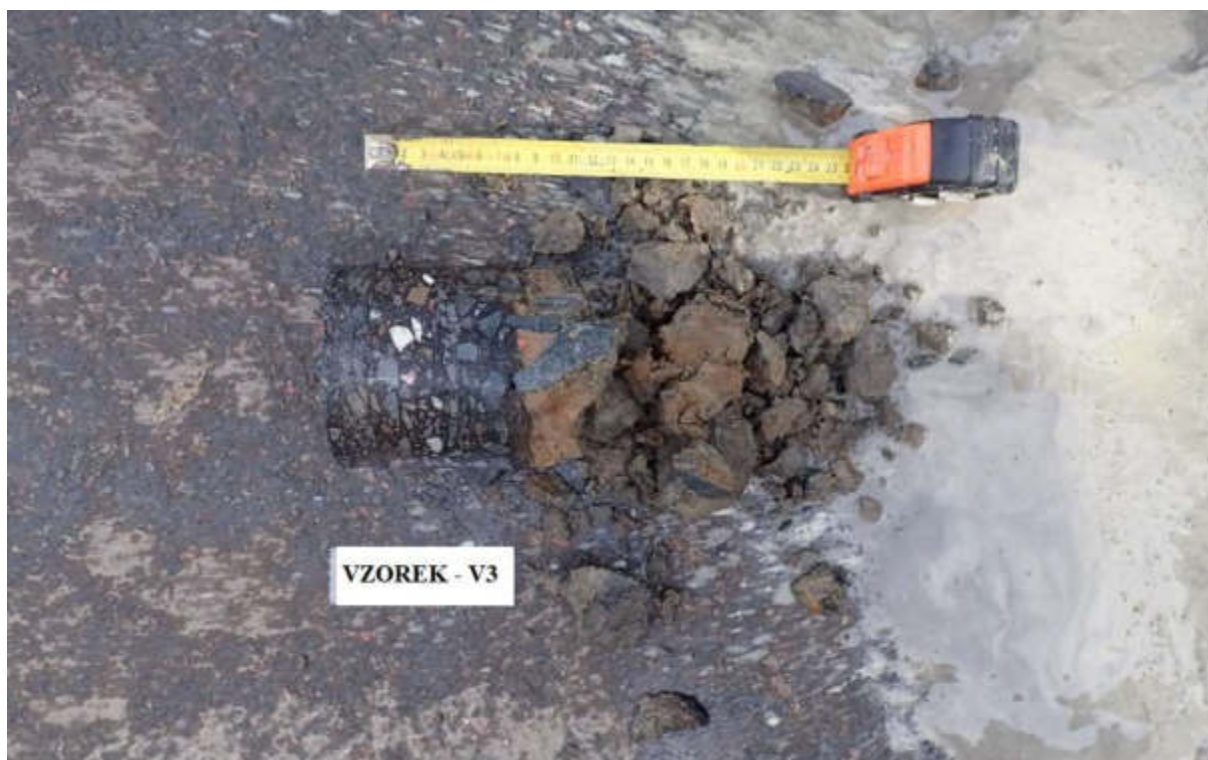
Obr. 5 - Jádro vývrtu Vzorek – V3 (in situ).
