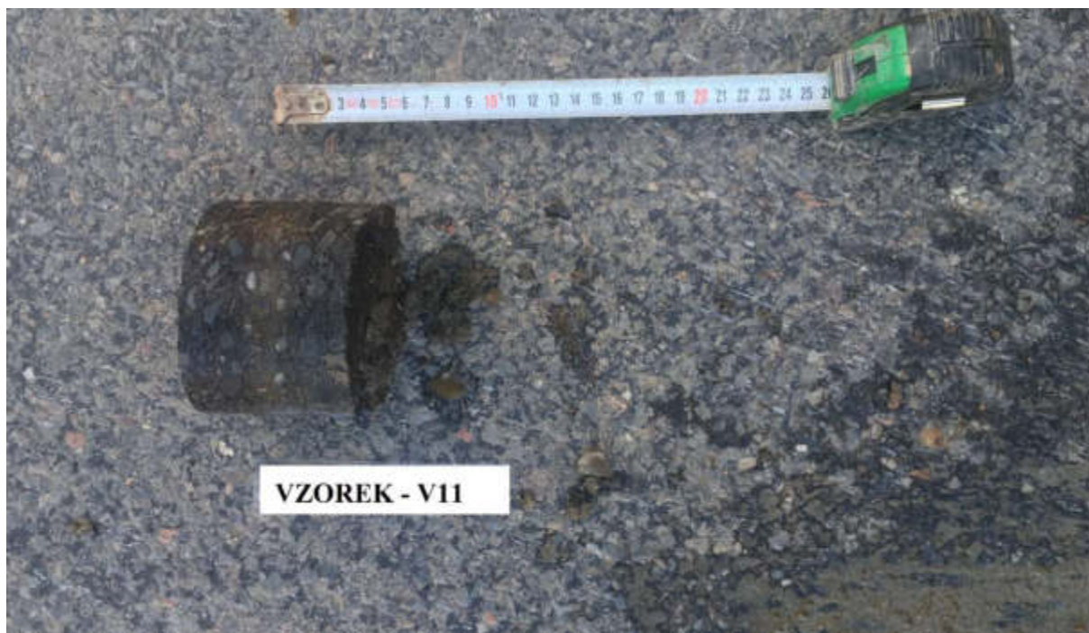
Obr. 15 - Jádro vývrtu Vzorek – V11(in situ).
