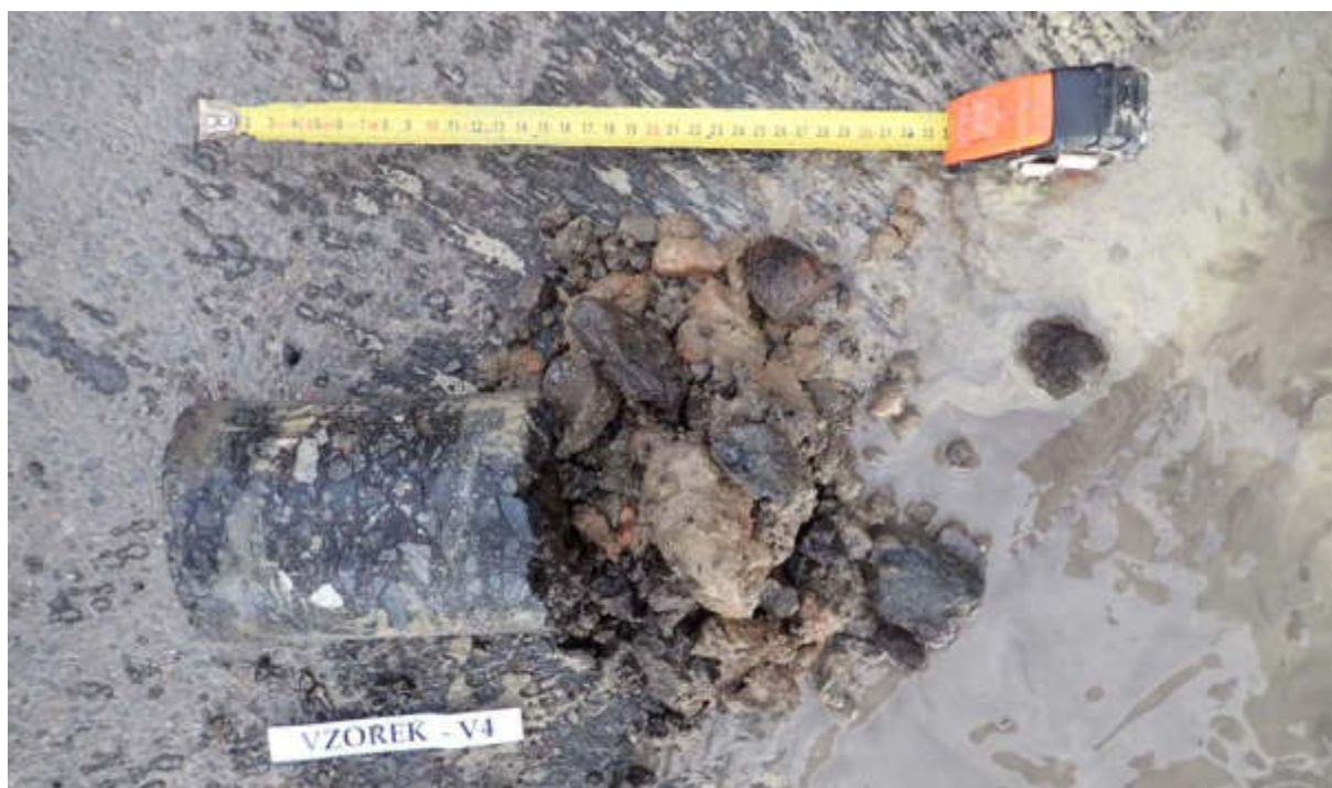
Obr. 7 - Jádro vývrtu Vzorek – V4 (in situ).
