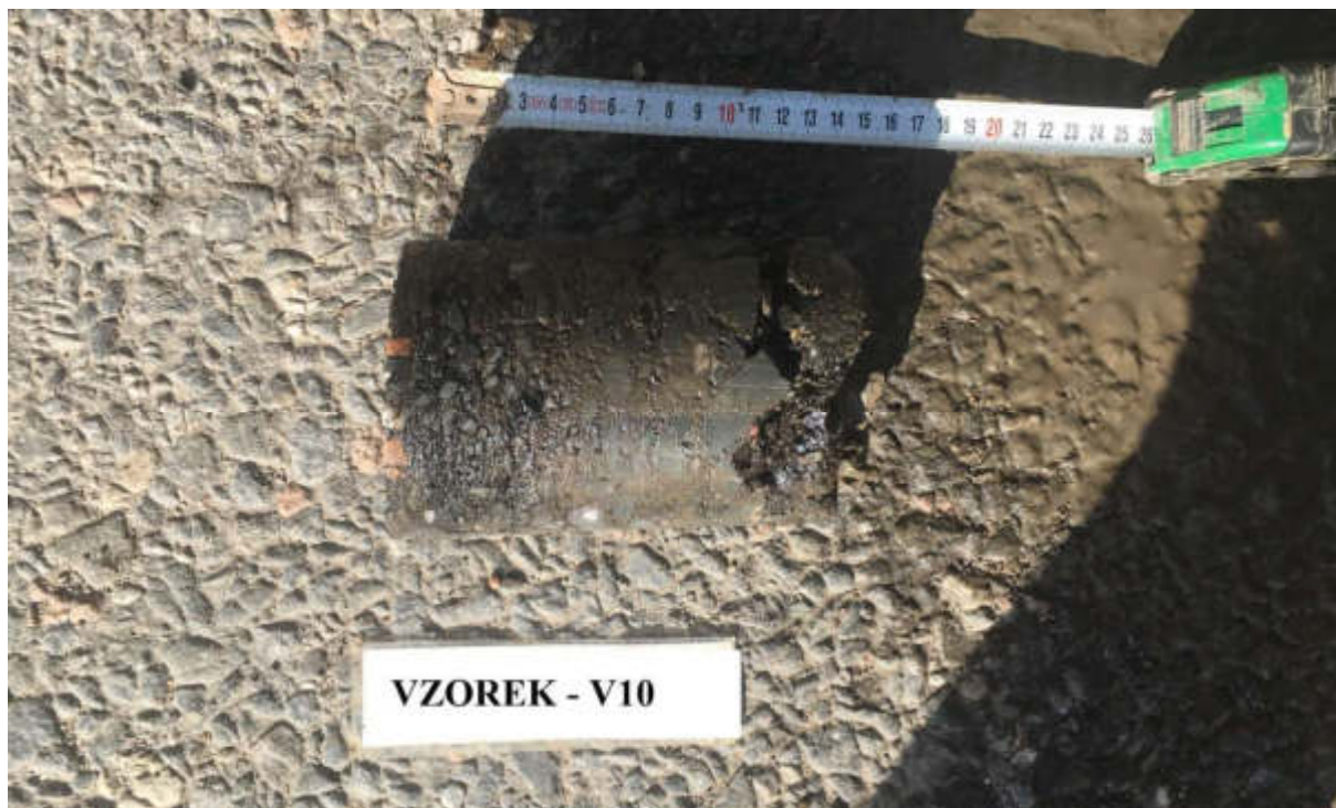
Obr. 13 - Jádro vývrtu Vzorek – V10 (in situ).
