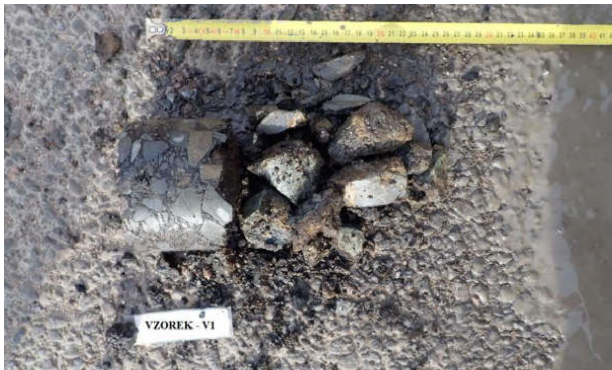
Obr. 1 - Jádro vývrtu Vzorek – V1 (in situ).
