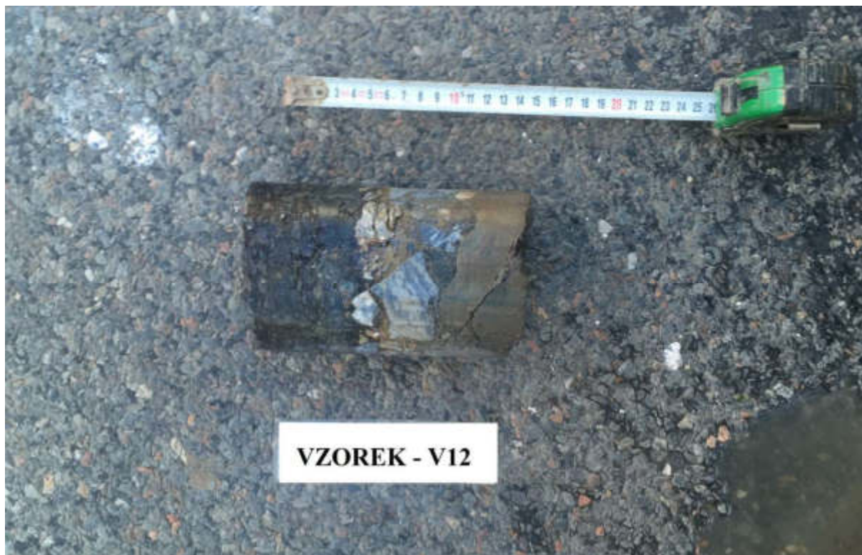
Obr. 17 - Jádro vývrtu Vzorek – V12 (in situ).
