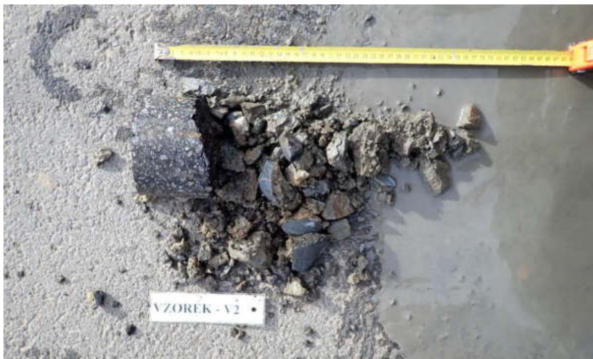
Obr. 3 - Jádro vývrtu Vzorek – V2 (in situ).
