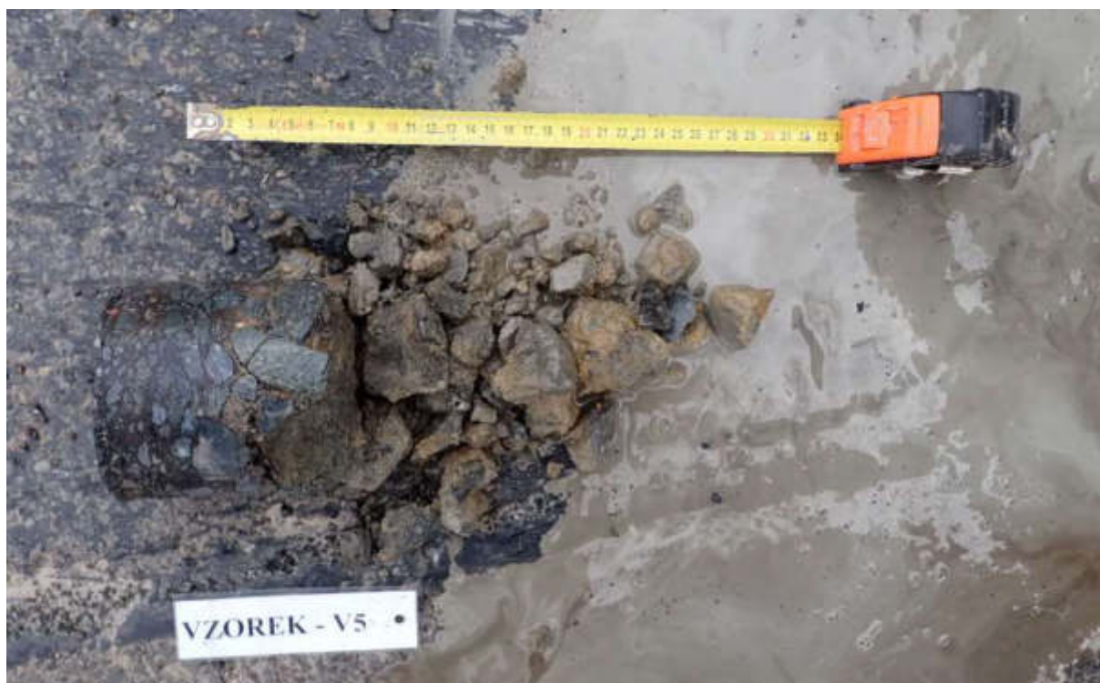
Obr. 9 - Jádro vývrtu Vzorek – V5 (in situ).
