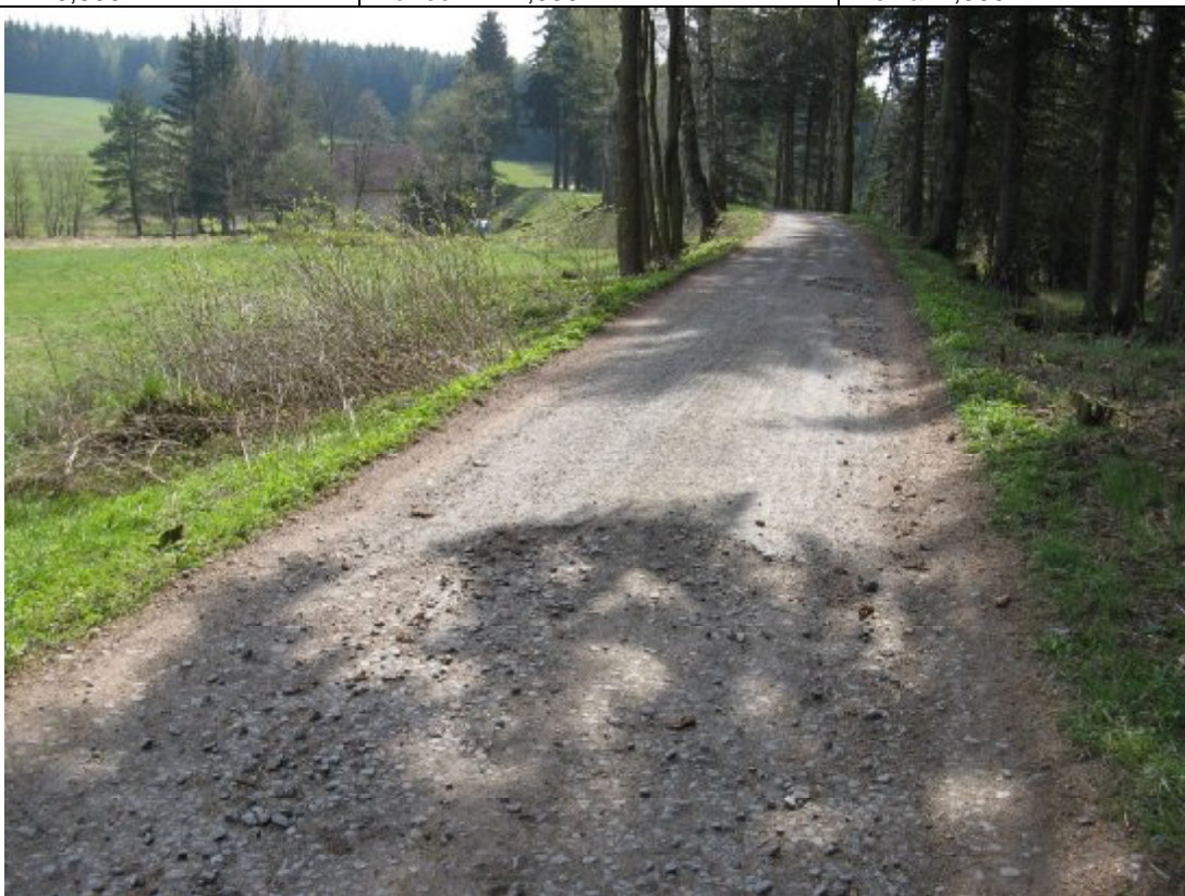
F27, km 0,860+ Rozpad povrchu.
