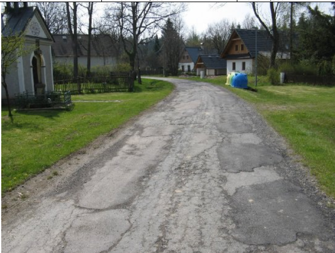
F13, km 0,510+ Vysprávký, koroze-opotřebený nátěr.
