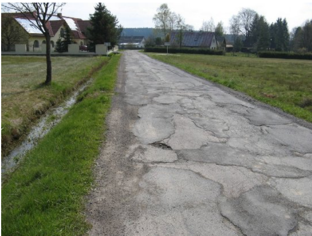
F07, km 0,210+ Nepravidelné hrboly, vysprávký, výtlučky, nefunkční odvodnění.
