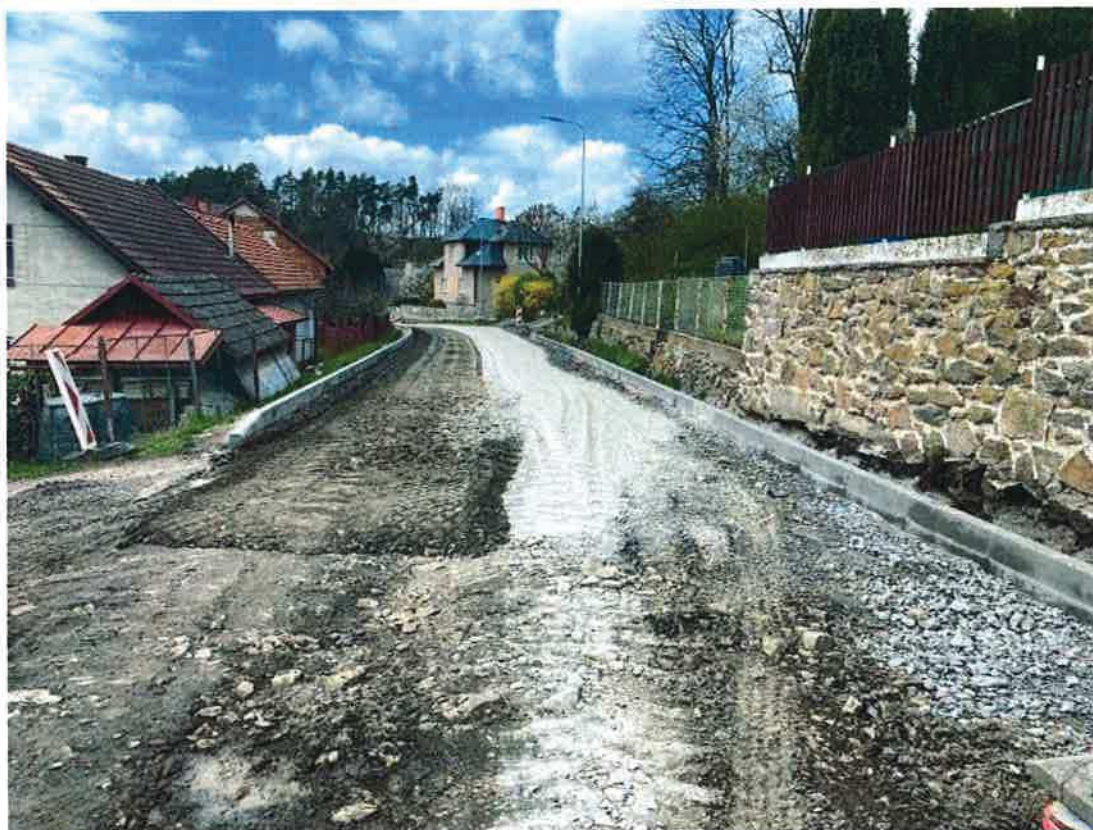
Sanace neúnosného a podmáčeného podloží
