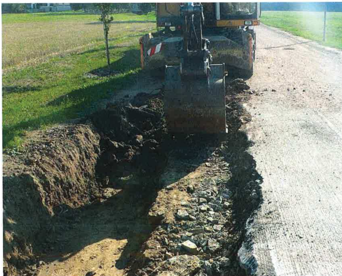
Sanace neúnosného a podmáčeného podloží
