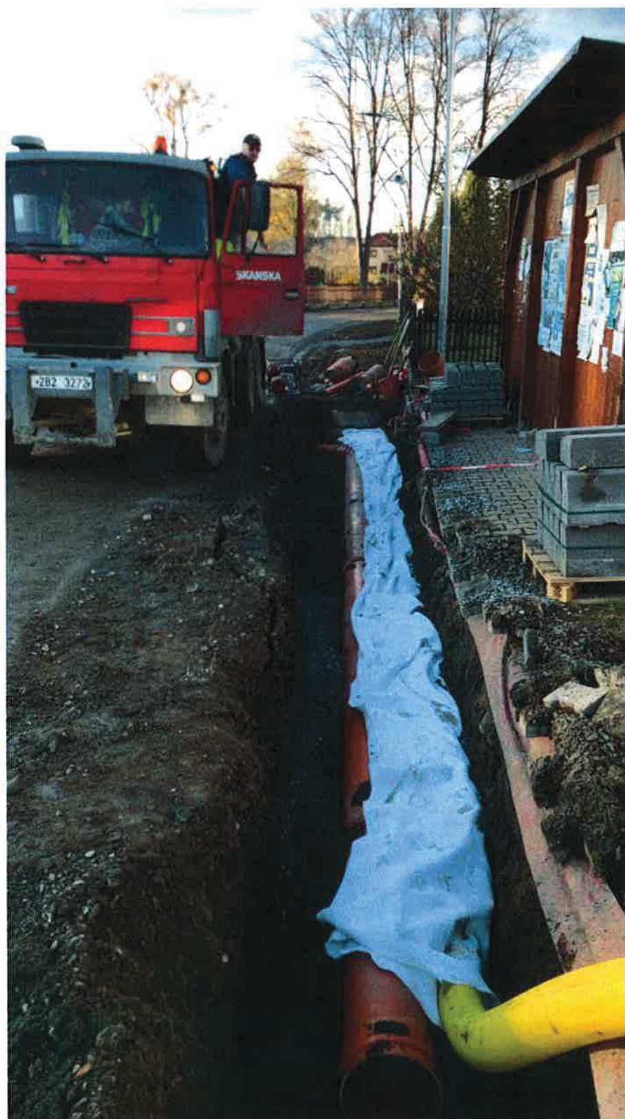
Oprava kanalizace v úseku km 3,455 - 3,498
