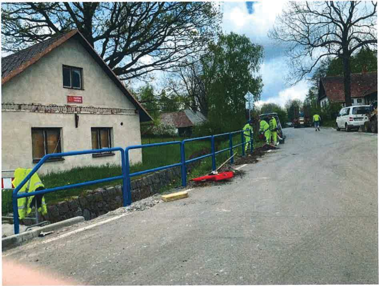
Zábradlí u koryta vodoteče
