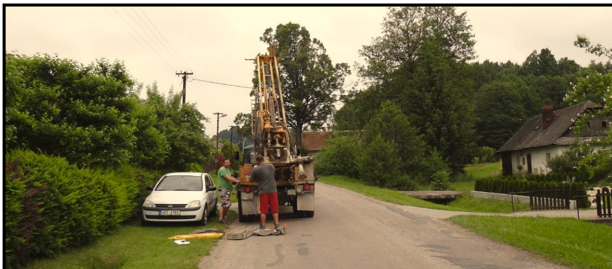
Obr. č. 9: Hloubení sondy HT-5
