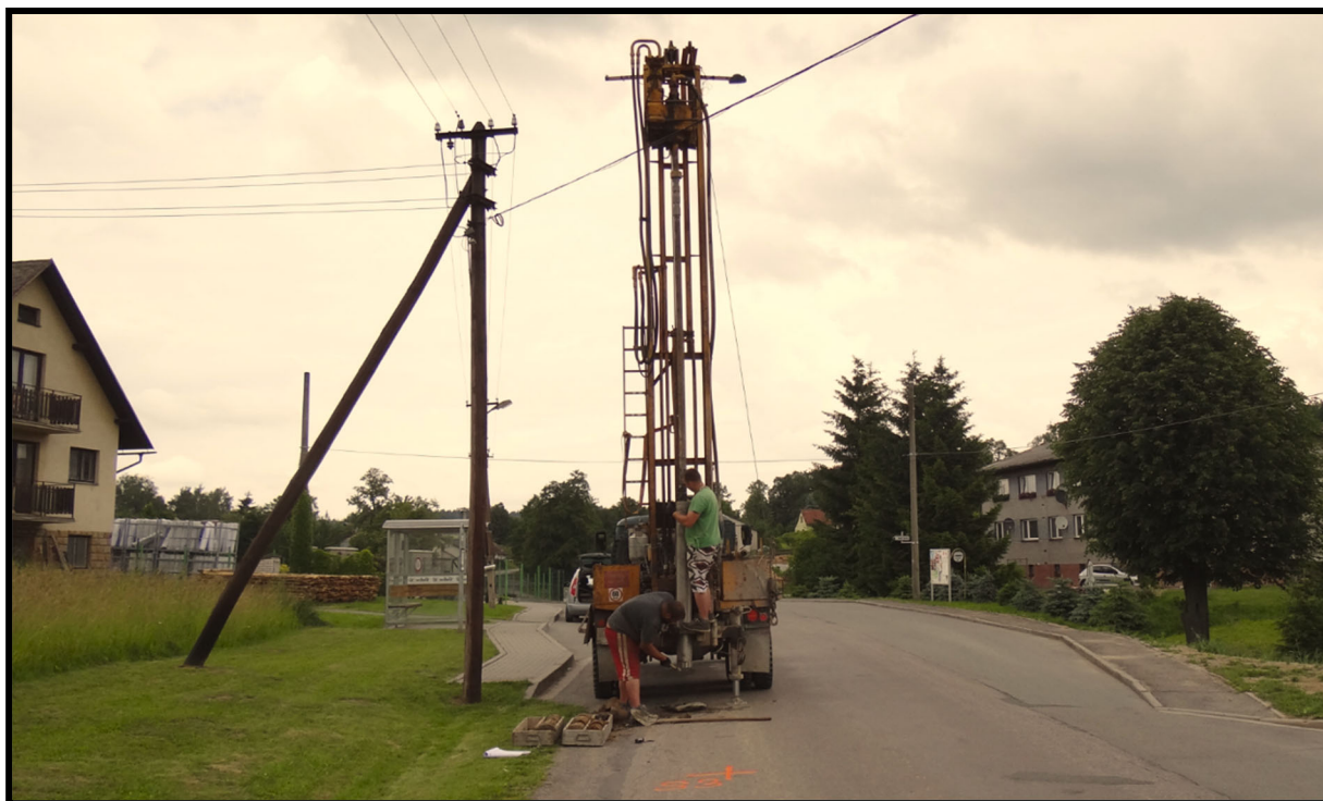
Obr. č. 5: Hloubení sondy HT-3
