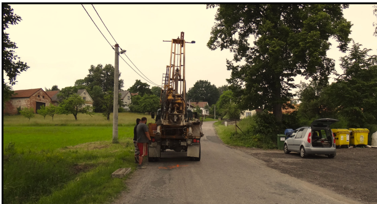
Obr. č. 13: Hloubení sondy HT-7
