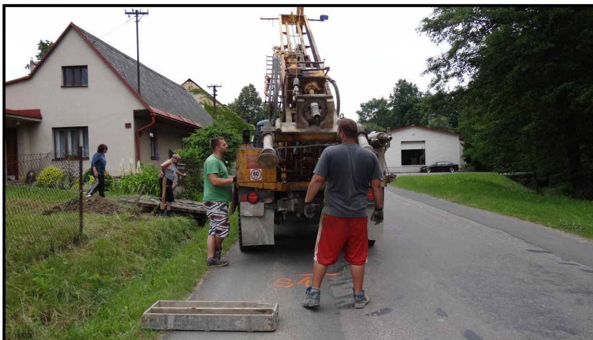
Obr. č. 7: Hloubení sondy HT-4
