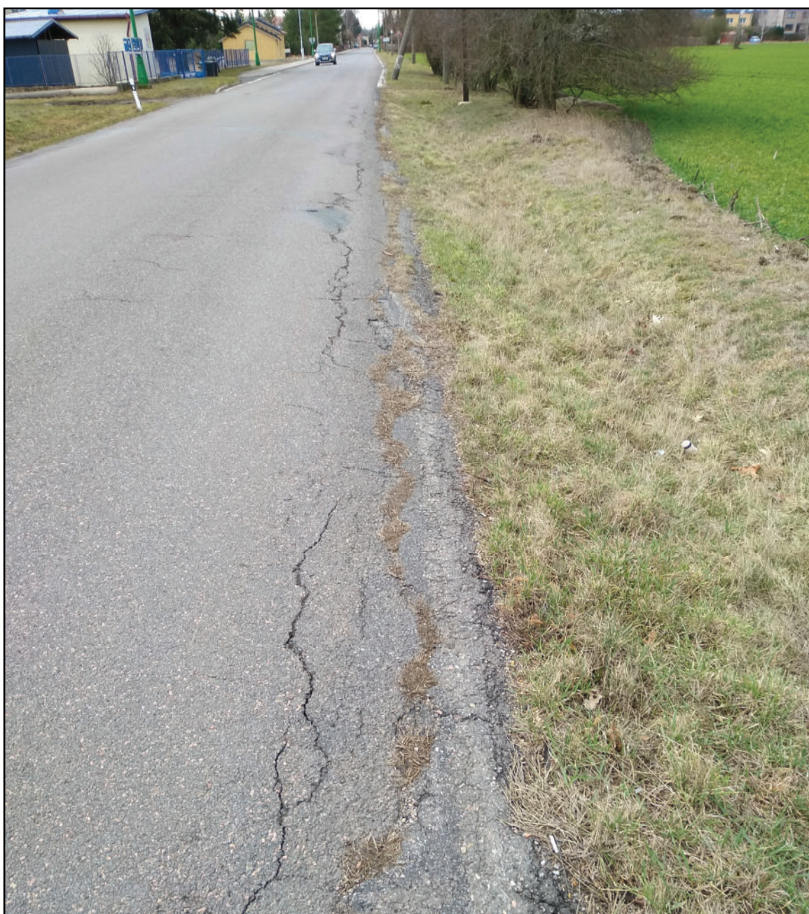
Obr. 5 – Poruchy vozovky – trhliny a sedání okrajů vozovky
