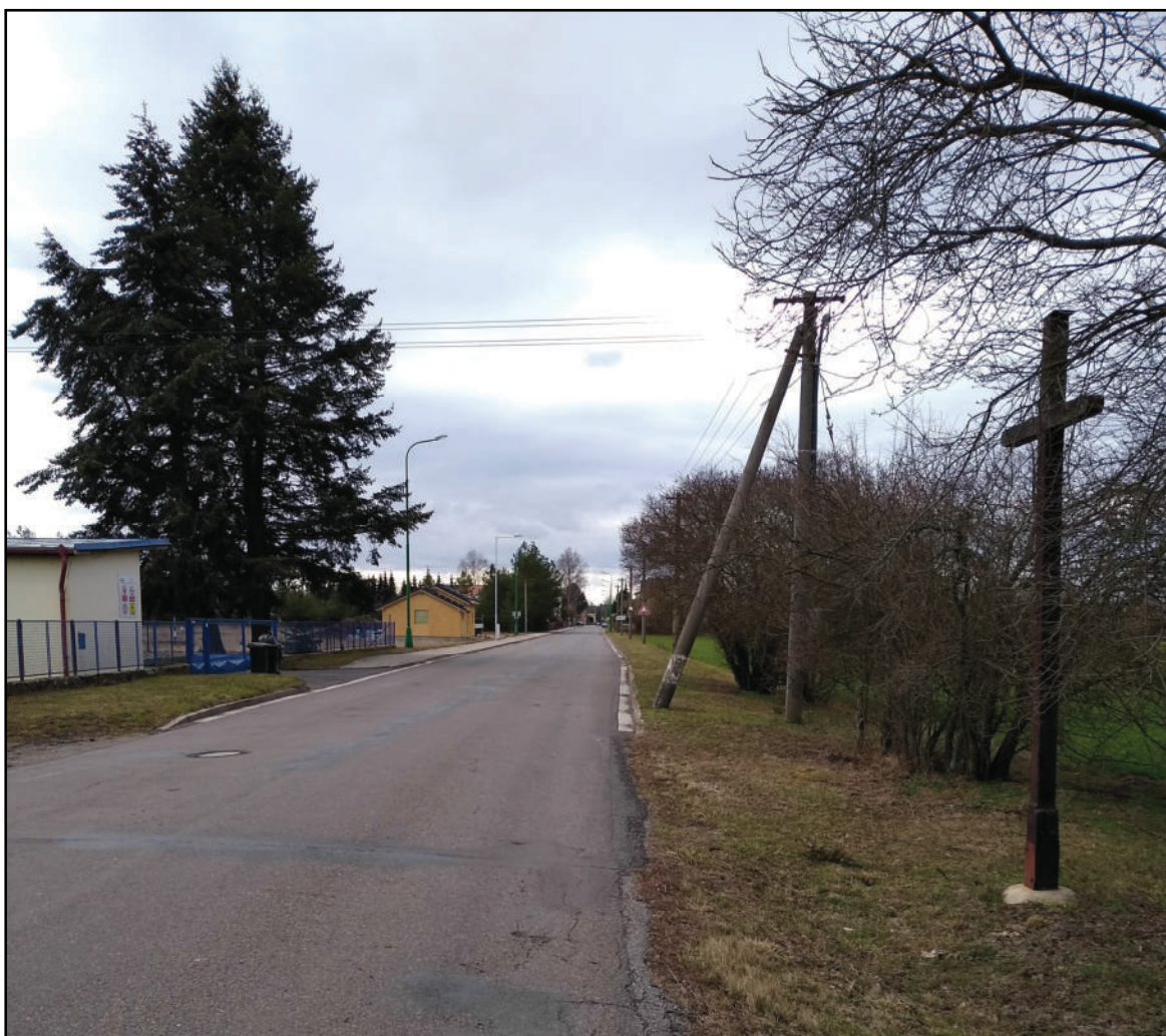
Obr. 4 – Překážka v blízkosti silnice – betonová opěra sloupu VN
