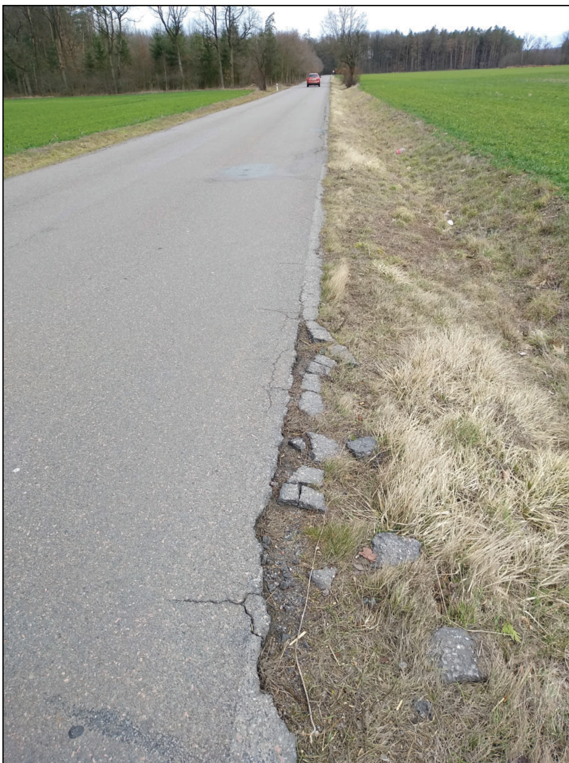
Obr. 6 – Poruchy vozovky – ulámaný kryt, chybějící podkladní vrstvy u kraje vozovky
