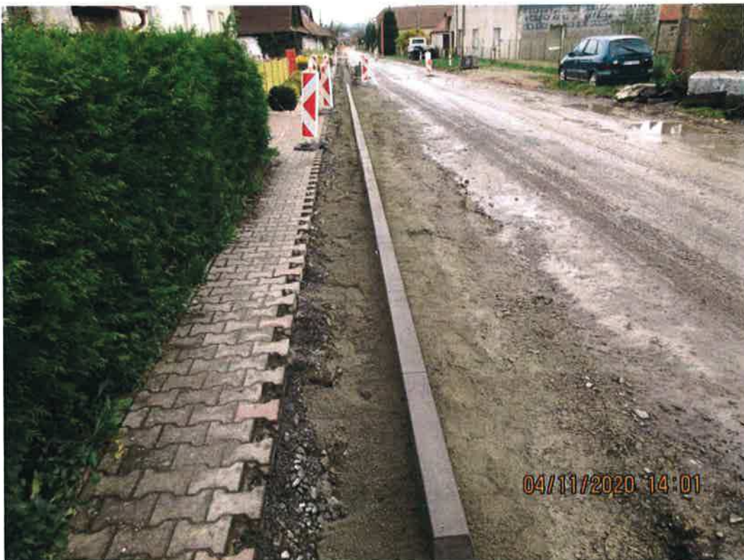
2 - Výšková úprava obrub při sanaci
