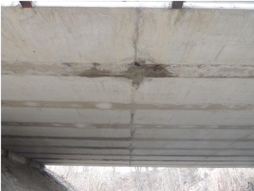
Pohled na spáru mezi jednotlivými dílci nosníků nosné konstrukce
