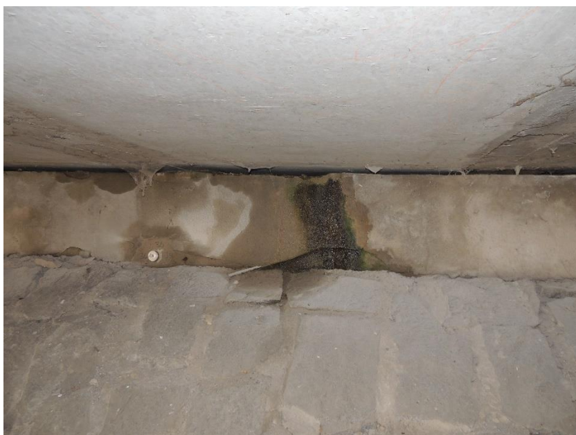
Pohled na stopy po zatékání na povrchu betonu levé opěry
