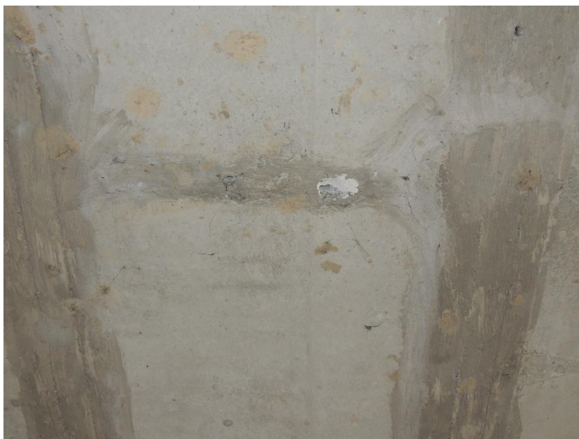
Místo provedení sondovacích vrtů k předpínací výztuži do nosníku N5
