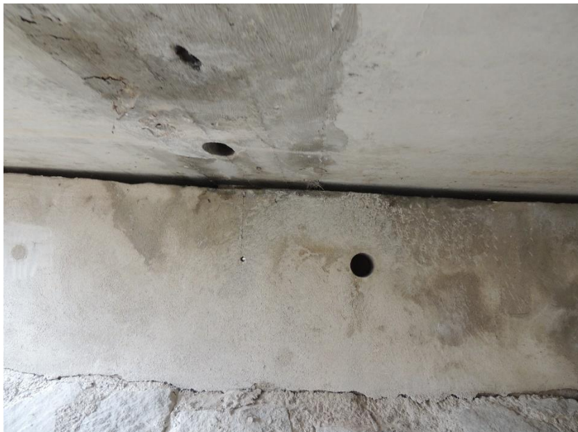
Pohled na místo odběru vzorku betonu z levé opěry mostu a z betonu spáry mezi nosníky N1 a N2
