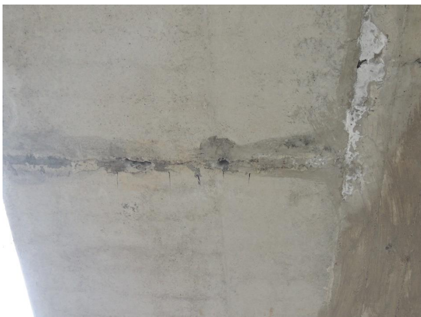
Místo provedení sondovacích vrtů k předpínací výztuži do nosníku N9
