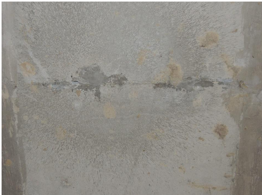
Místo provedení sondovacích vrtů k předpínací výztuži do nosníku N4
