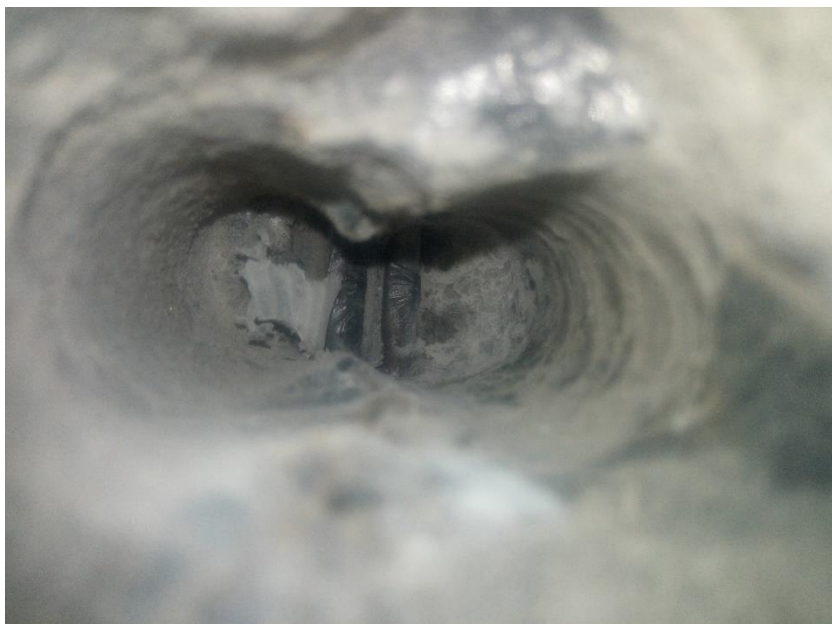
Pohled do sondy k předpínací výztuži nosníku N3
