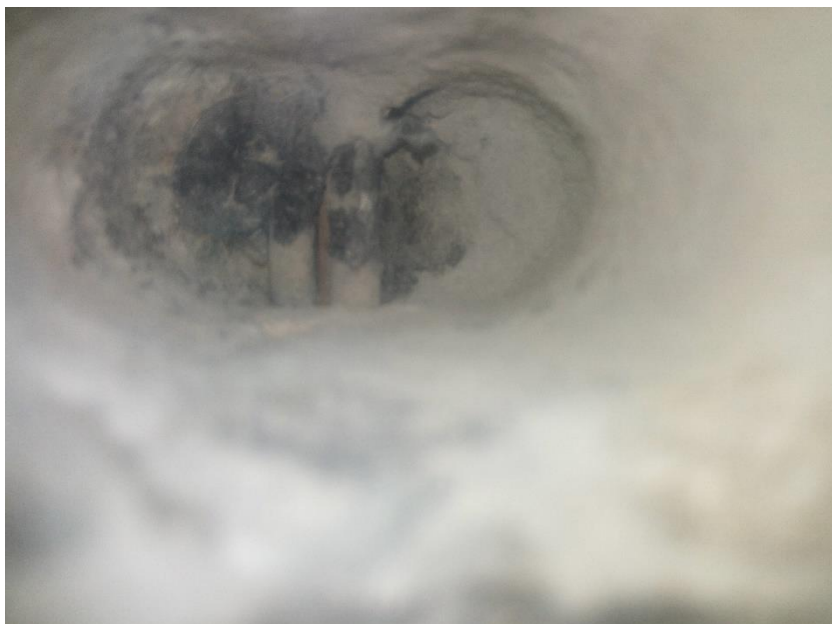
Pohled do sondy k předpínací výztuži nosníku N9
