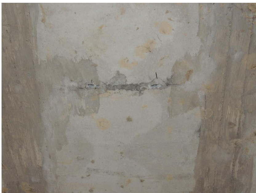
Místo provedení sondovacích vrtů k předpínací výztuži do nosníku N6
