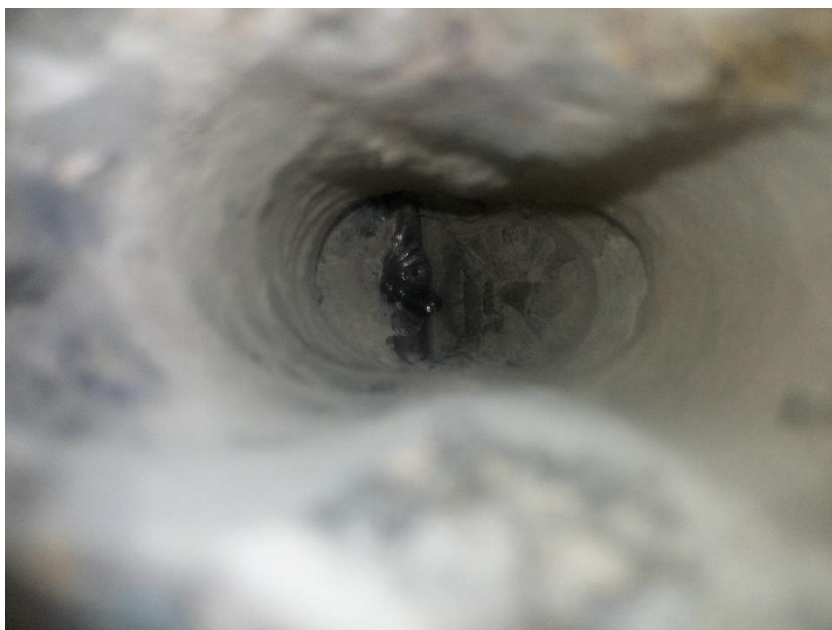
Pohled do sondy k předpínací výztuži nosníku N2
