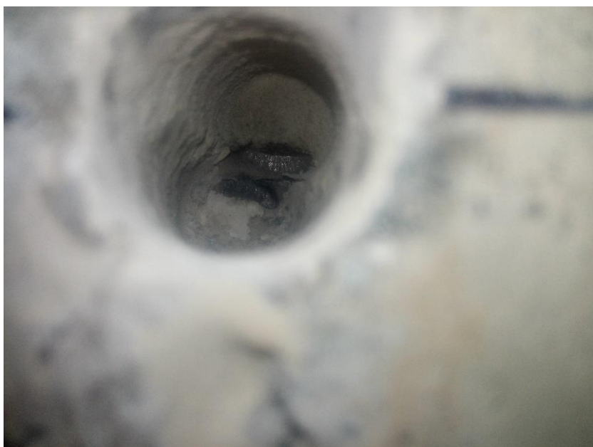
Pohled do sondy k předpínací výztuži nosníku N1
