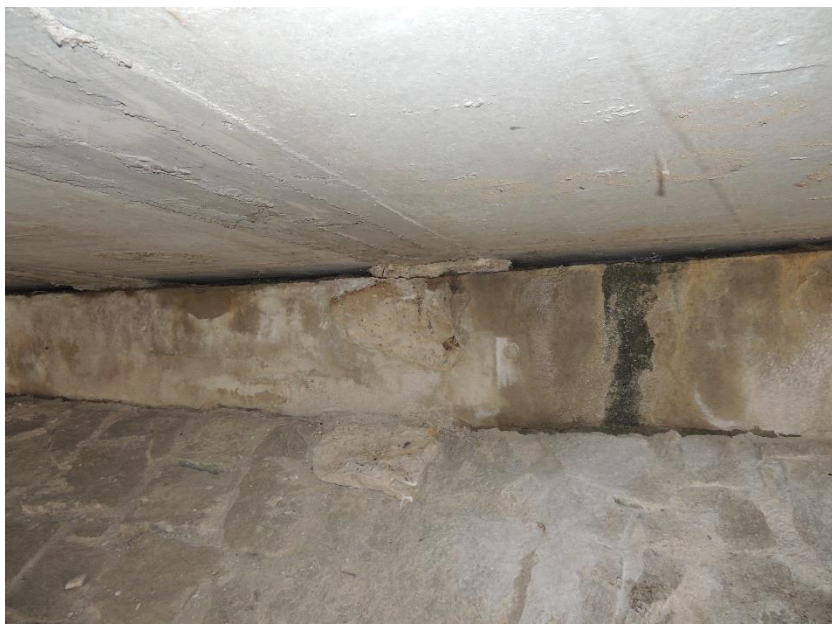
Pohled na delaminovanou krycí vrstvu betonu nad výztuží pravé opěry
