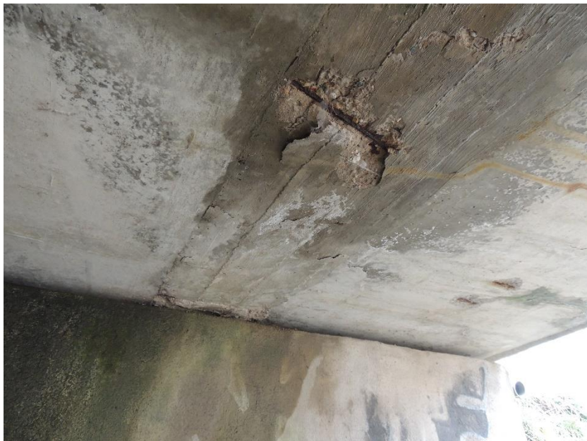
Pohled na obnaženou korodující výztuž v betonu spáry mezi nosníky
