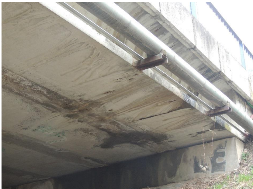
Pohled na stopy po zatékání na podhledu nosné konstrukce mostu
