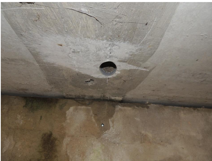
Místo odběru vzorku betonu ze spáry mezi nosníky N4 a N5
