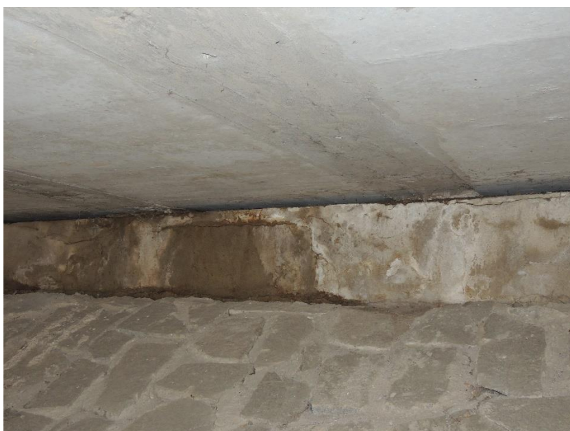
Pohled na stopy po zatékání na povrchu betonu pravé opěry
