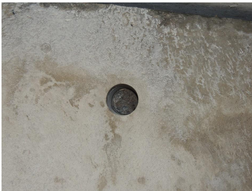
Pohled do otvoru po odběru vzorku betonu z levé opěry
