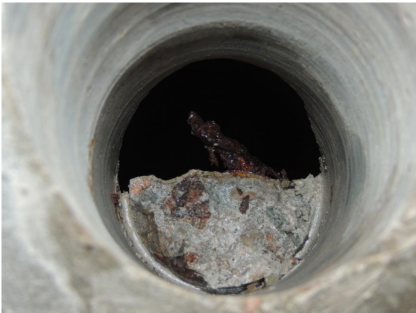
Viditelná korodující výztuž v otvoru po odběru vzorku betonu ze spáry mezi nosníky N1 a N2
