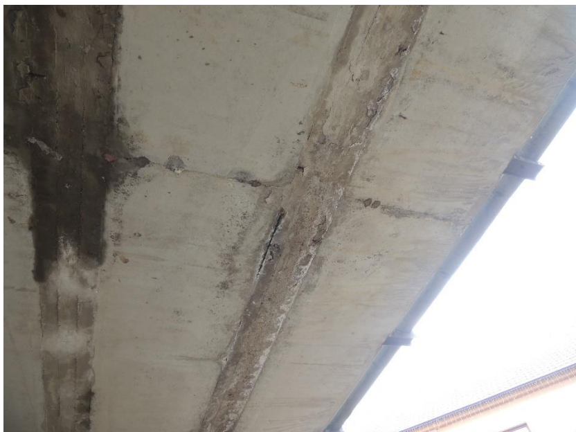
Stopy po zatékání na spodním povrchu betonu spáry mezi nosníky nosné konstrukce
