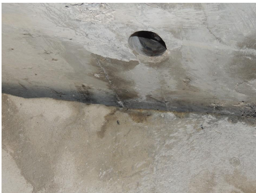
Místo odběru vzorku betonu ze spáry mezi nosníky N1 a N2
