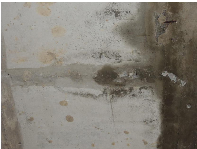
Místo provedení sondovacích vrtů k předpínací výztuži do nosníku N3
