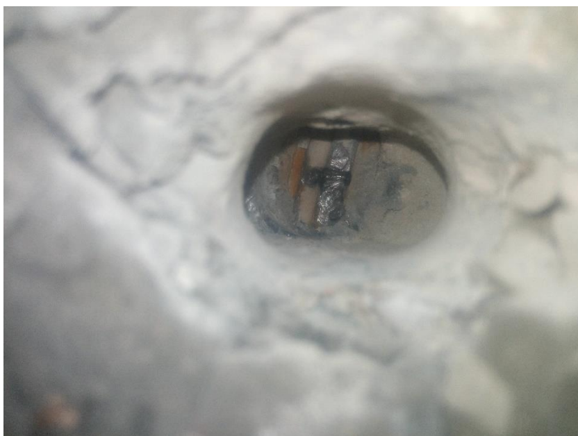
Pohled do sondy k předpínací výztuži nosníku N5
