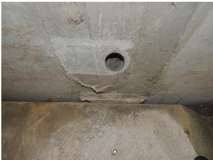
Místo odběru vzorku betonu ze spáry mezi nosníky N3 a N4
