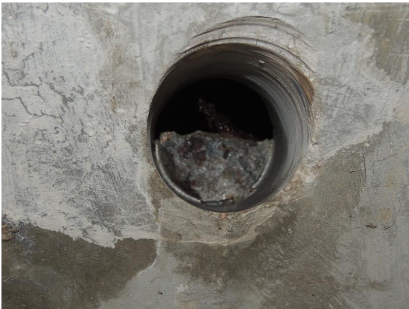
Pohled do otvoru po odběru vzorku betonu ze spáry mezi nosníky N1 a N2
