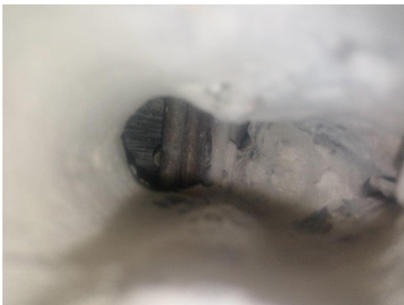
Pohled do sondy k předpínací výztuži nosníku N4
