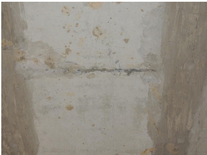
Místo provedení sondovacích vrtů k předpínací výztuži do nosníku N7
