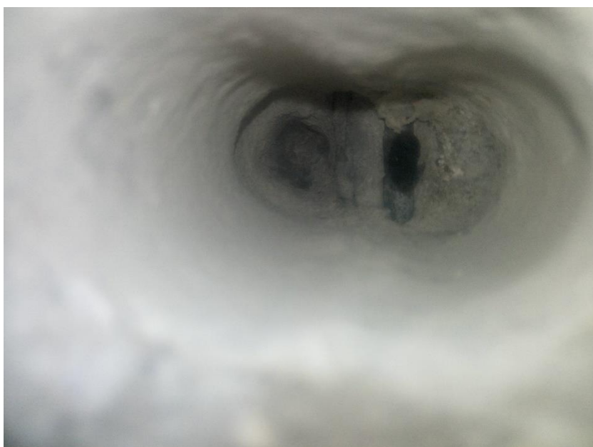
Pohled do sondy k předpínací výztuži nosníku N8
