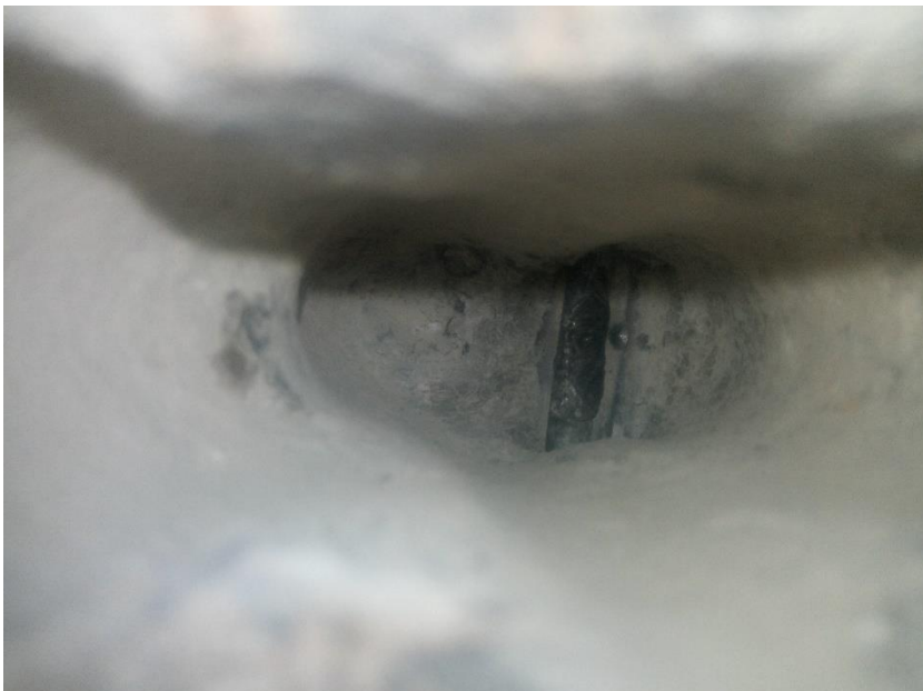
Pohled do sondy k předpínací výztuži nosníku N6
