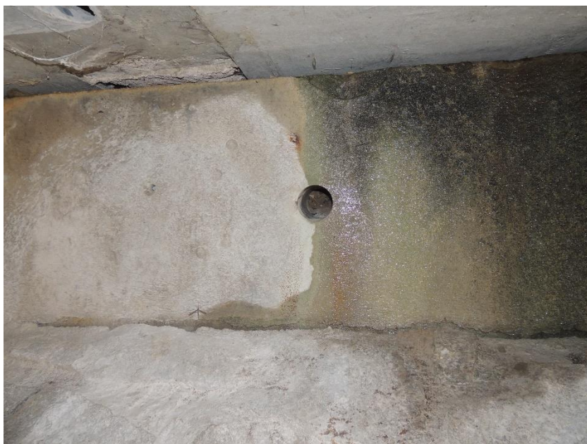
Místo odběru vzorku betonu z pravé opěry mostu
