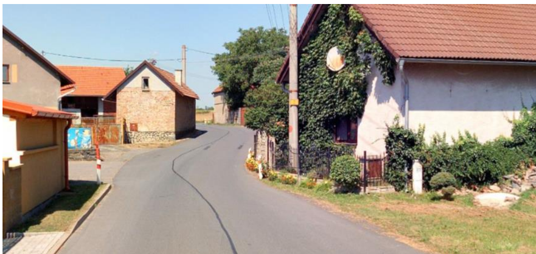
Obrázek 7: III/33810 Lipovec – Podhořany vyžaduje doplnit směrové sloupky a vodorovné značení
