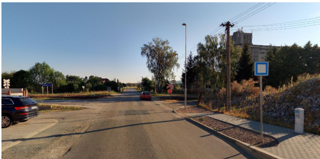
Obrázek 5: III/33810 Nádražní v Ronově nad Doubravou – snadno přehlédnutelný železniční přejezd vyžaduje zvýraznění optickou psychologickou brzdou z obou stran
