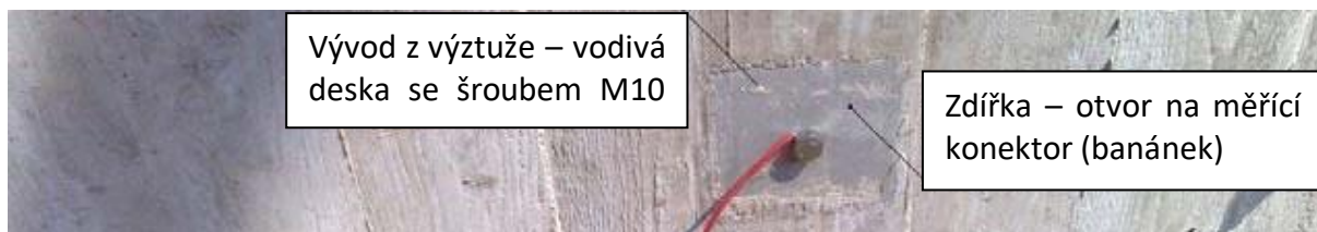
Obrázek č. 6: Schema elektricky vodivého pospojování výztuže pilot a patek (pro stupeň 3 nepovinný):
